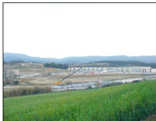
Fotografía 3: Polígono industrial en construcción
